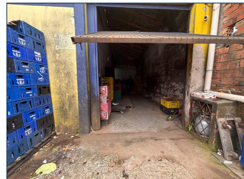
06 – Entrada do Depósito (Matrícula 17.861)
