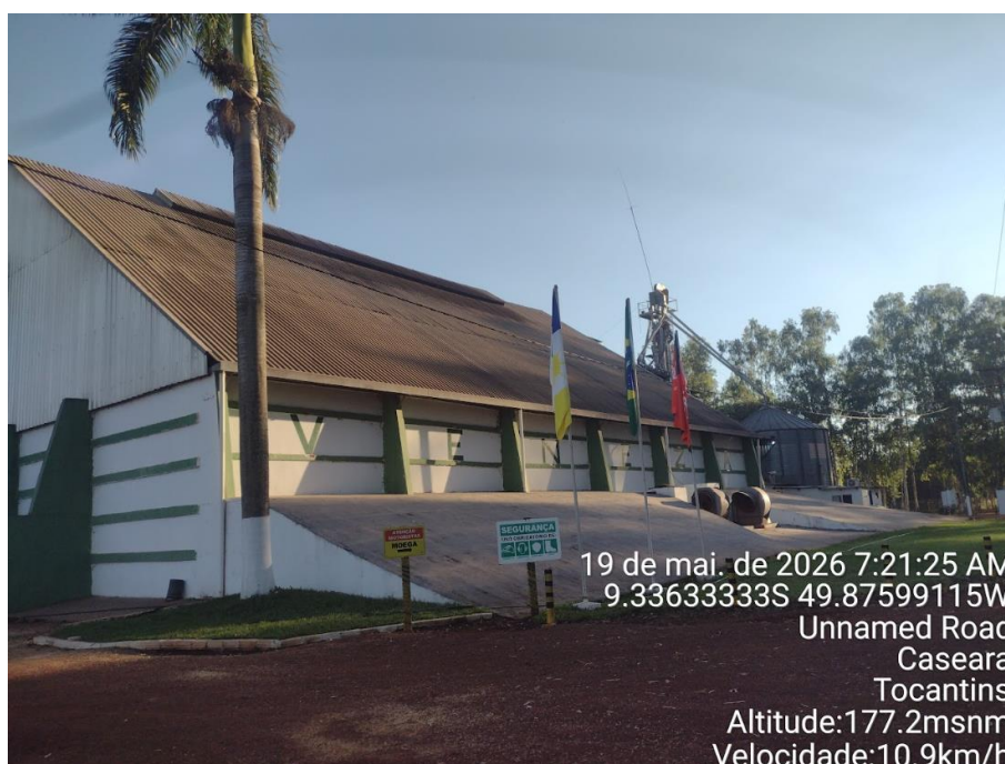
Imagem 44: Armazém graneleiro de grande porte
