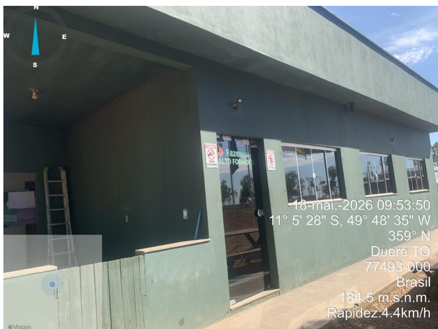
Imagem 38 Estrutura de apoio operacional
