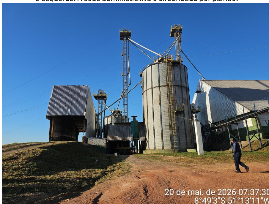
Imagem 22. Estrutura de armazenagem da Fazenda Vale Sereno, com presença de silo graneleiro, elevadores, moegas e galpões operacionais, utilizada para recebimento, movimentação e conservação da produção agrícola.
