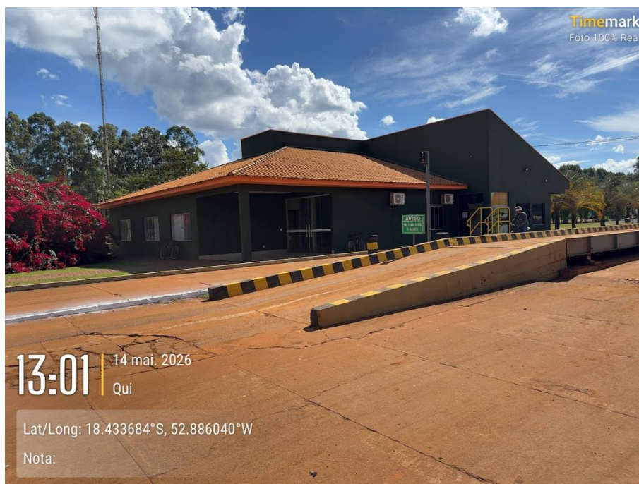
Imagem 8. Balança rodoviária e estrutura administrativa da unidade, utilizadas para controle de entrada e saída de cargas, suporte logístico e gestão operacional da produção agrícola.
