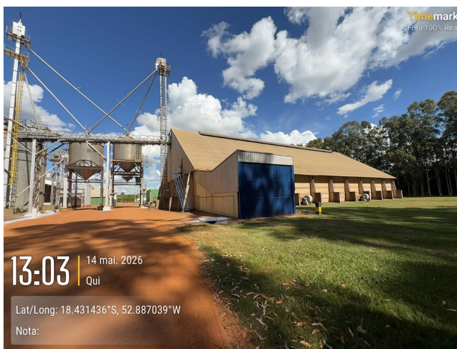
Imagem 7. Estrutura de armazenagem e beneficiamento de grãos, com presença de silos, elevadores, moegas e galpão operacional
