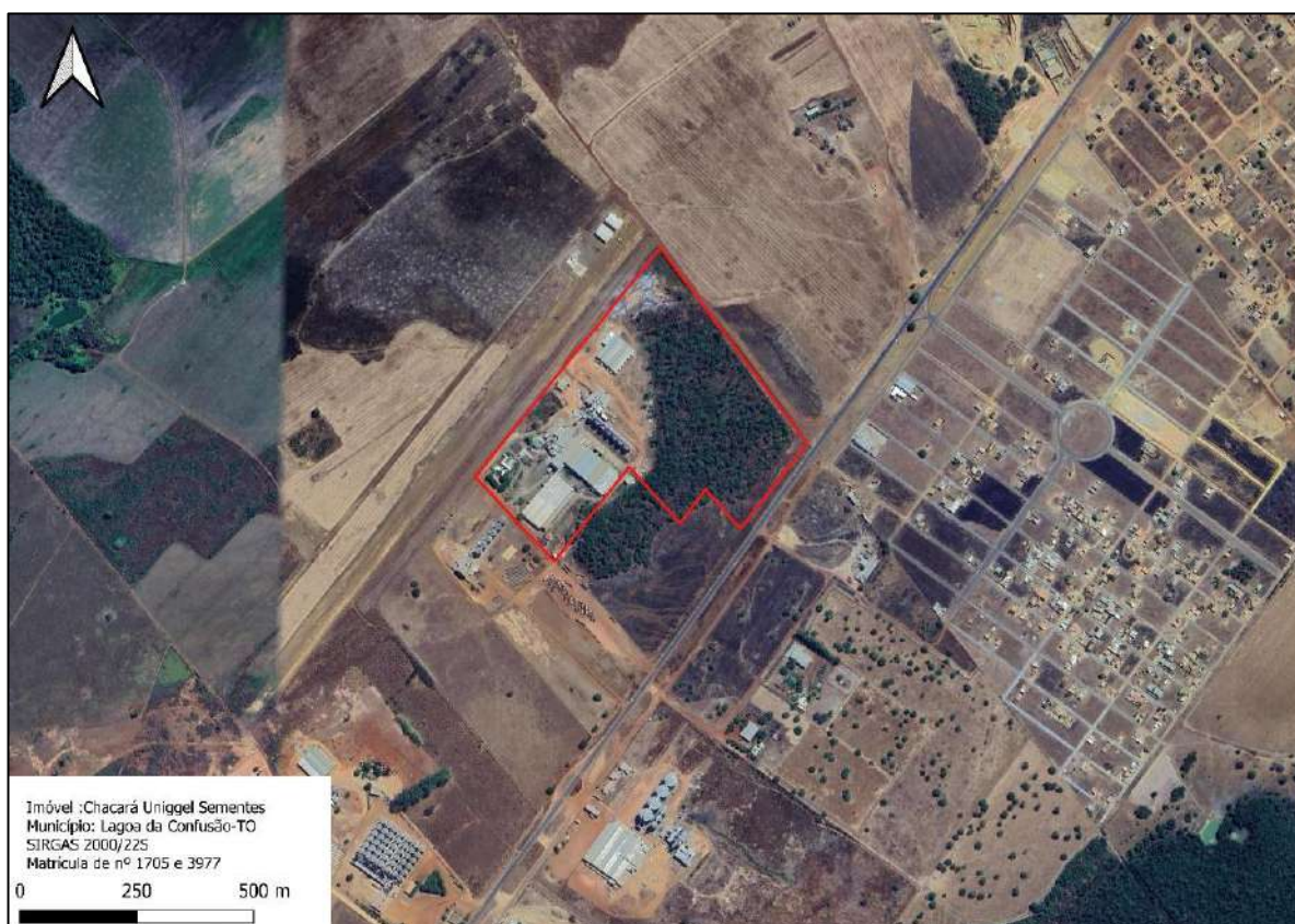
Figura 42. Unidade de Armazenamento no município de Lagoa da Confusão TO.
