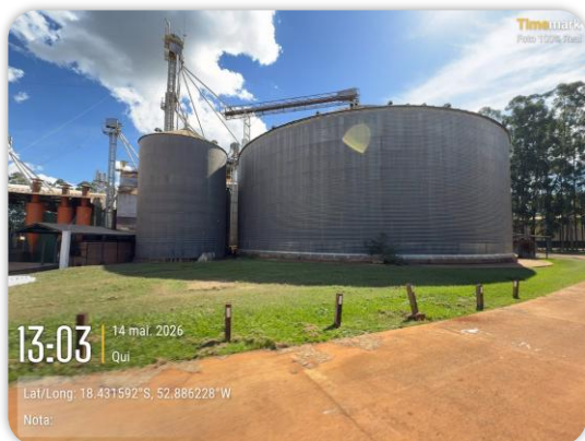
Foto 01: Silos de grande porte (Fazenda Santa Maria)
