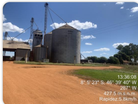
Foto 18: Silos de armazenamento (Chácara Ouro Verde)
