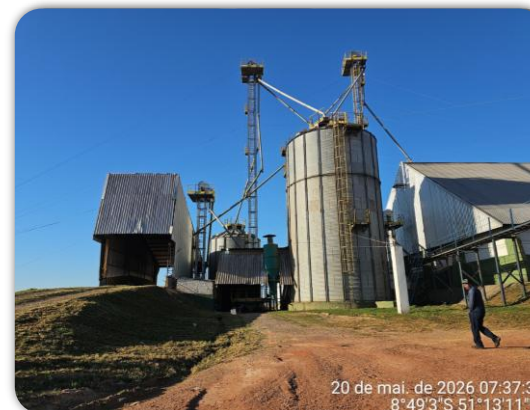
Foto 15: Estrutura de armazenagem (Fazenda Vale Sereno)
