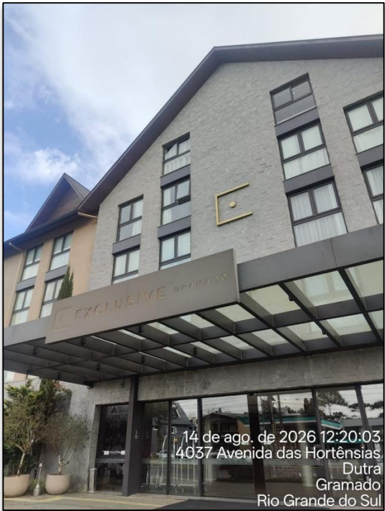
17. Fachada do hotel
