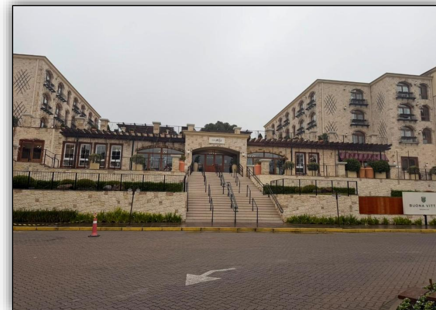
18. Fachada do hotel
