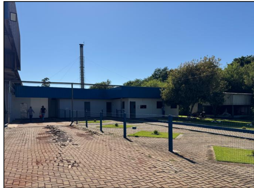
01 – Área externa da sede
