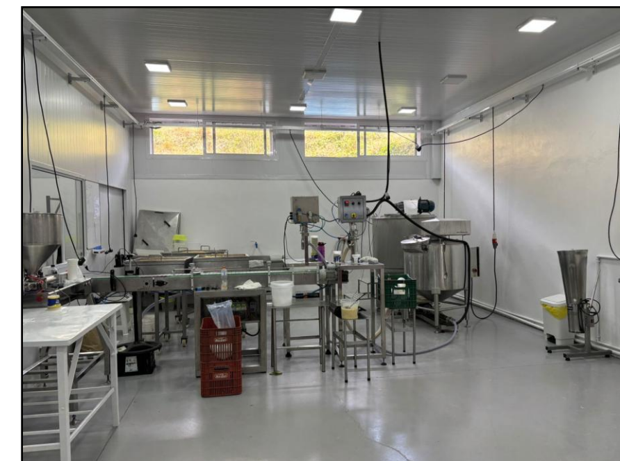
03 – Sala de máquinas
