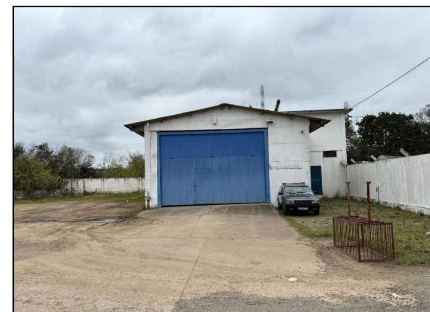
06. Galpão para veículos
