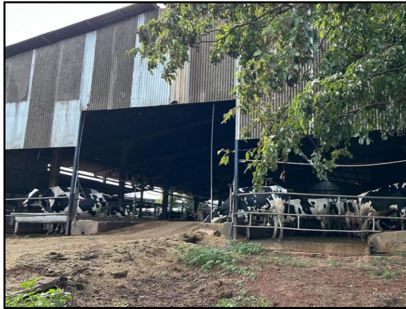
01 – Entrada do galpão
