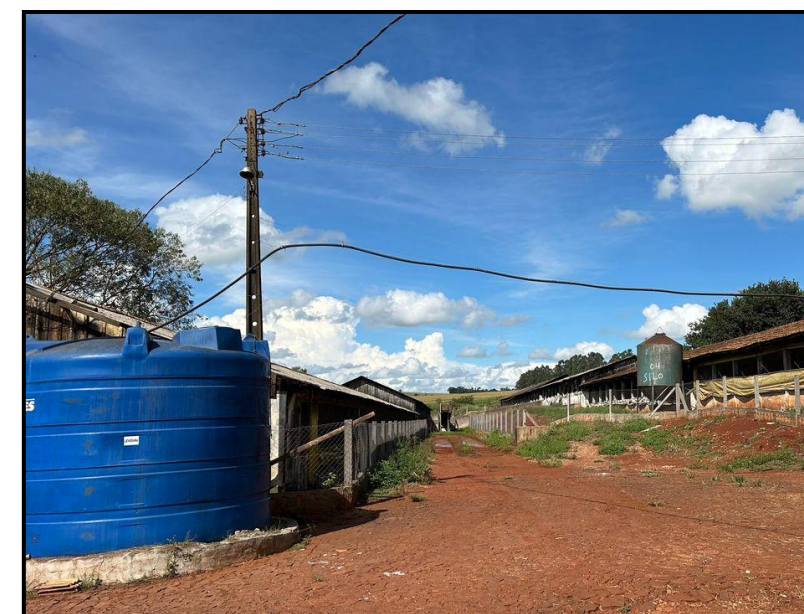
03 – Silos e infraestrutura
