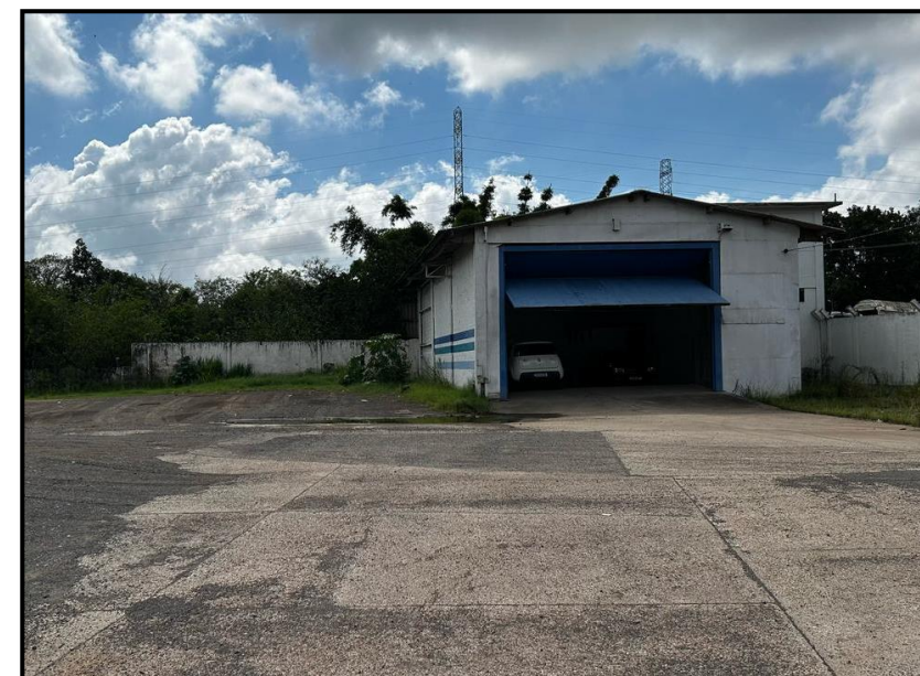
05. Galpão para estacionar veículos
