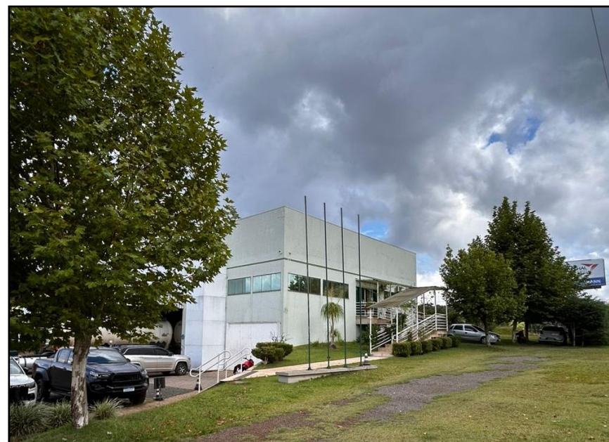
01. IG Transportes LTDA. – Fachada
