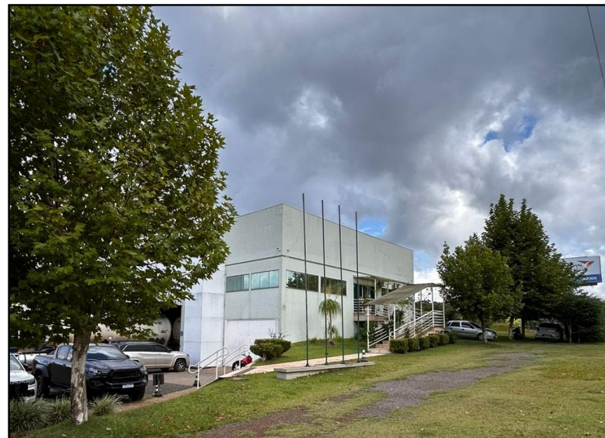
01. IG Transportes LTDA. – Fachada
