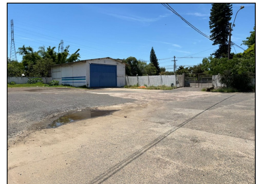
06. Galpão para veículos
