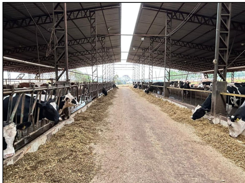
01 – Entrada do galpão
