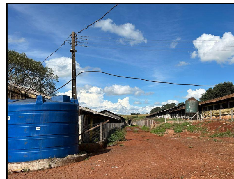
03 – Silos e infraestrutura
