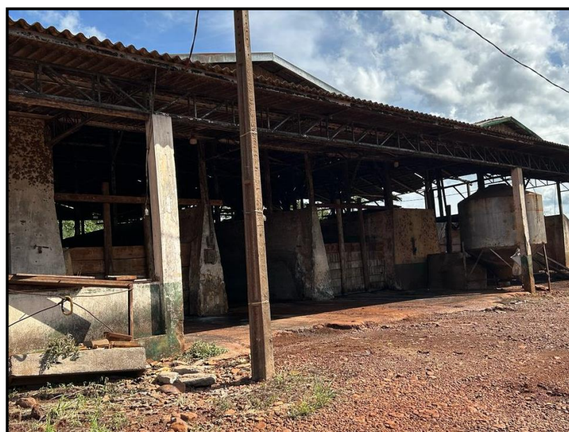
04 – Entrada do galpão de criação
