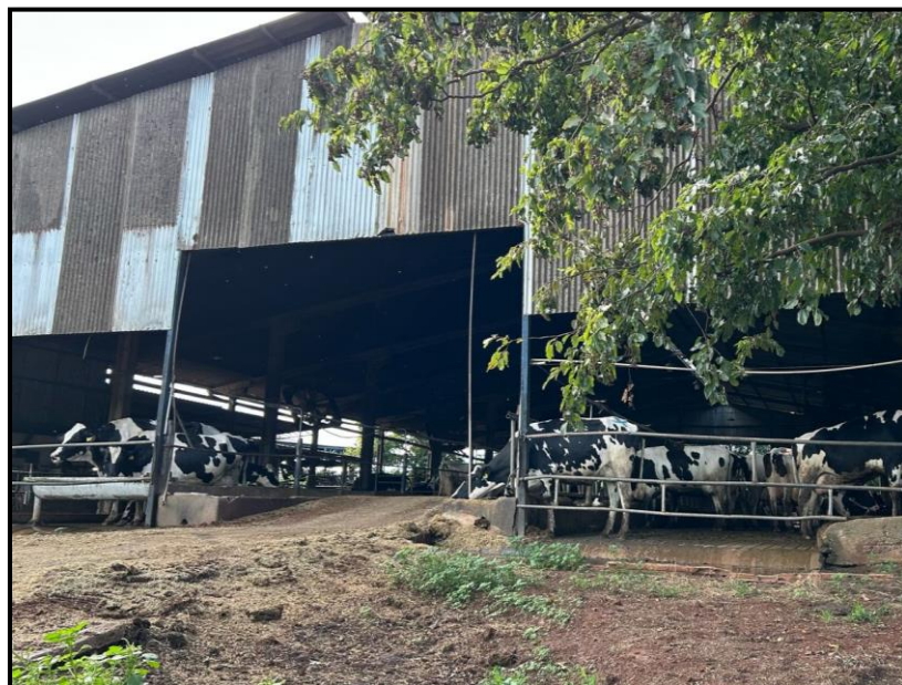
01 – Entrada do galpão
