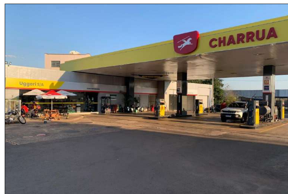
03 Filial - Fachada Avenida Ipiranga, 1301, Santo Ângelo/RS – Posto Charrua
