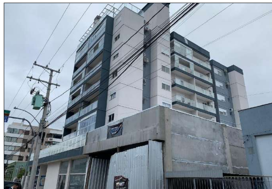
01 Ed. Buenos Aires - Fachada
