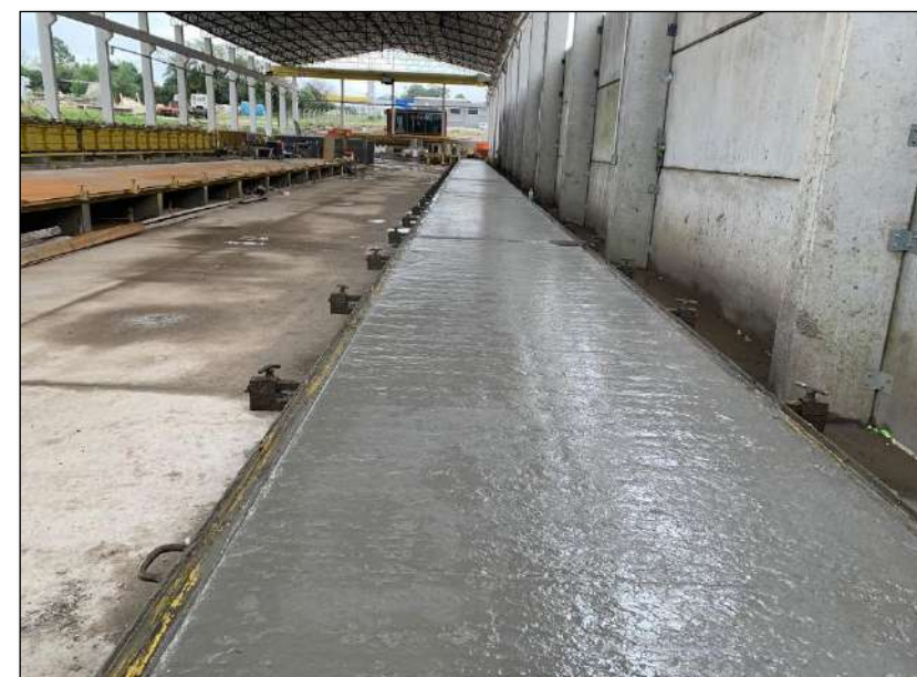
05 Interior da fábrica
