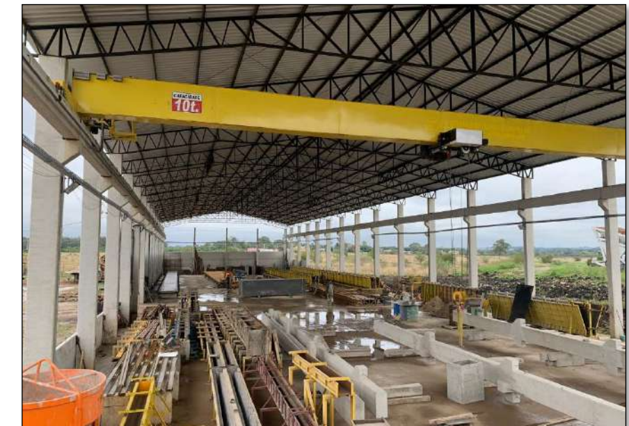
06 Interior da fábrica
