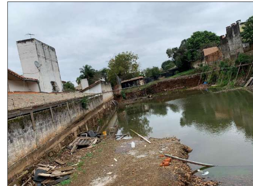
08 Residencial Córdoba - Interior
