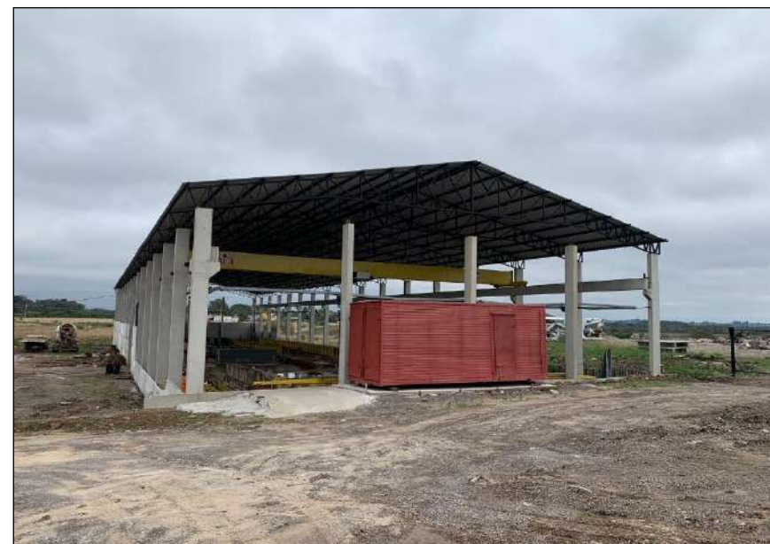
04 Fachada da fábrica
