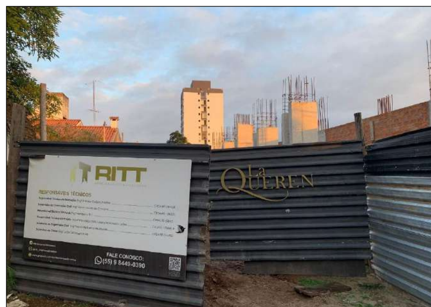
09 Residencial La Querência - Fachada
