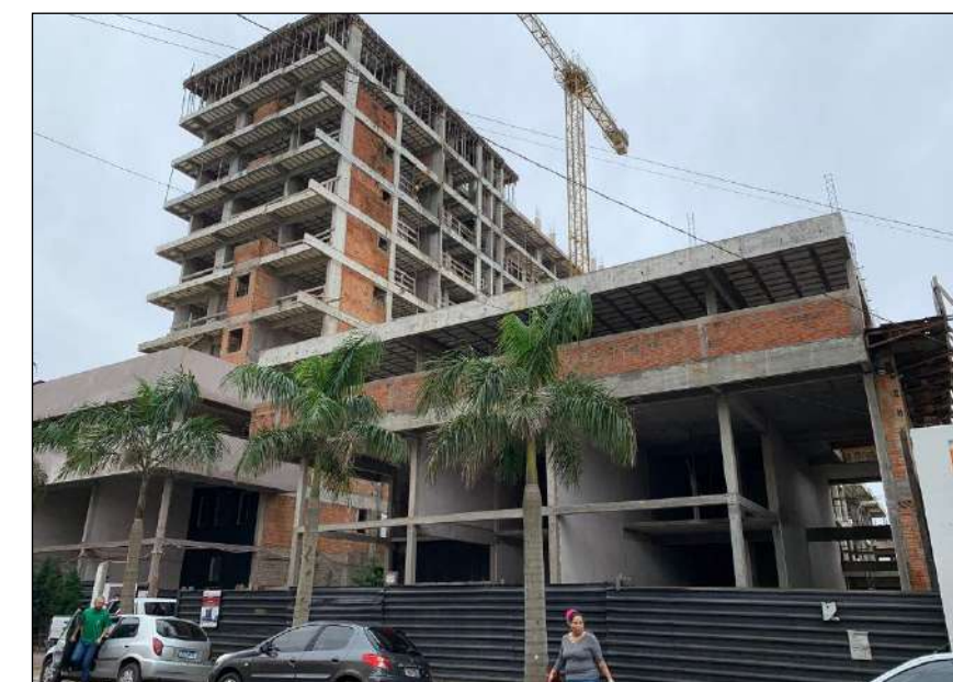
03 Residencial Évora - Fachada
