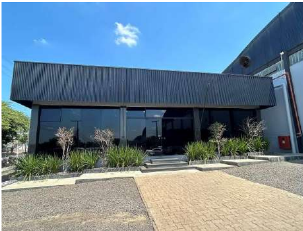
Vista externa – setor administrativo
