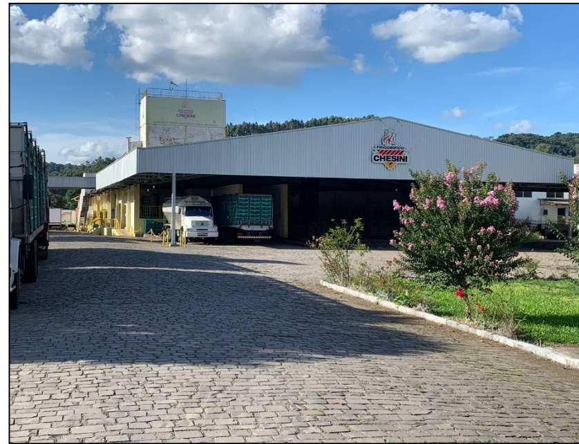
01. Estacionamento de veículos
