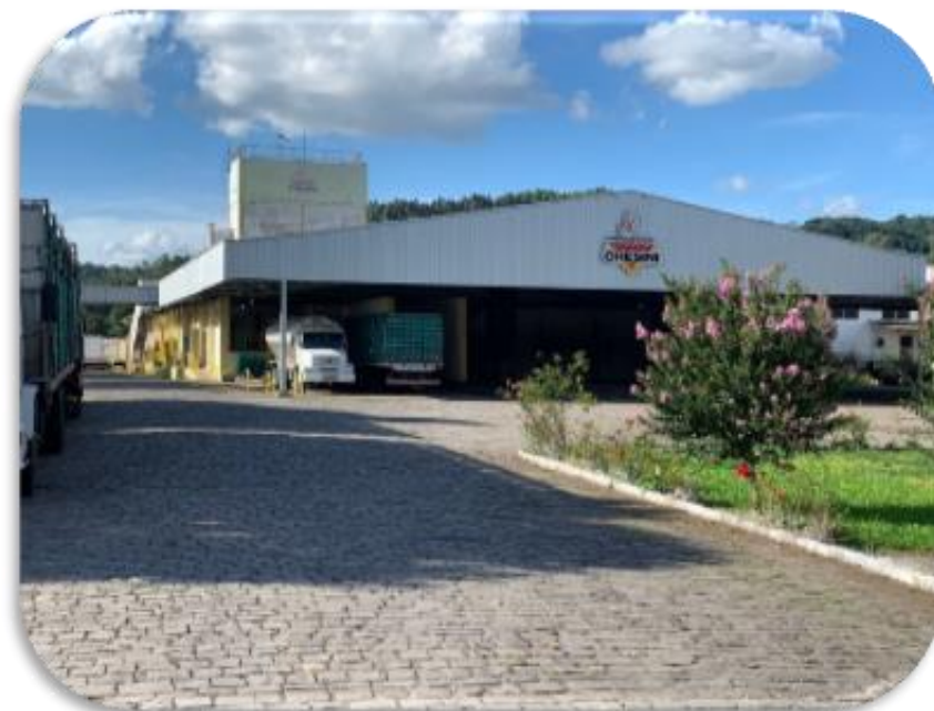
01. Estacionamento de veículos
