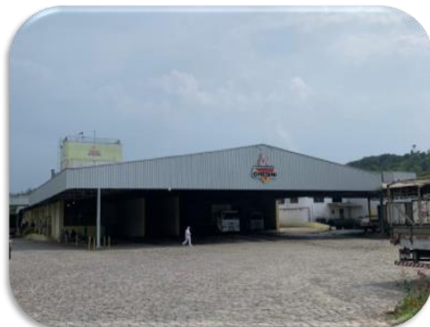
01. Estacionamento de veículos
