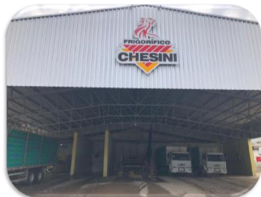
01. Estacionamento de veículos
