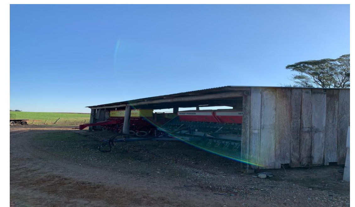
Local de Armazenamento
