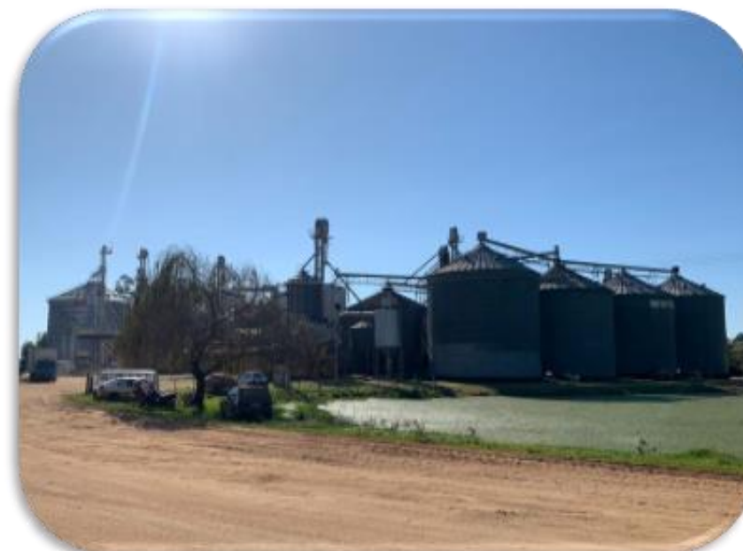
02. Silos armazenadores (Fazenda Santa Eulália)
