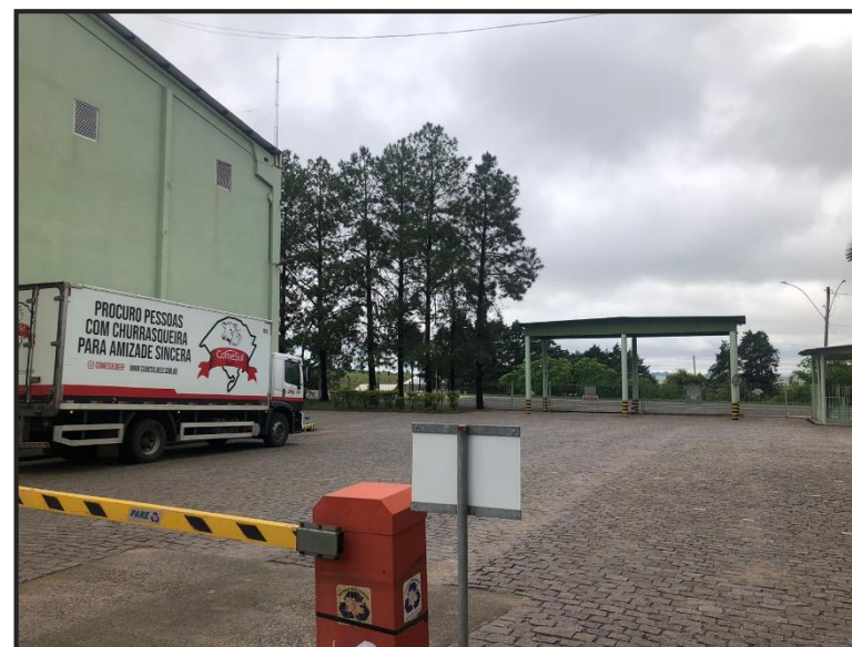
01. Parte externa da sede, em Pântano Grande/RS
