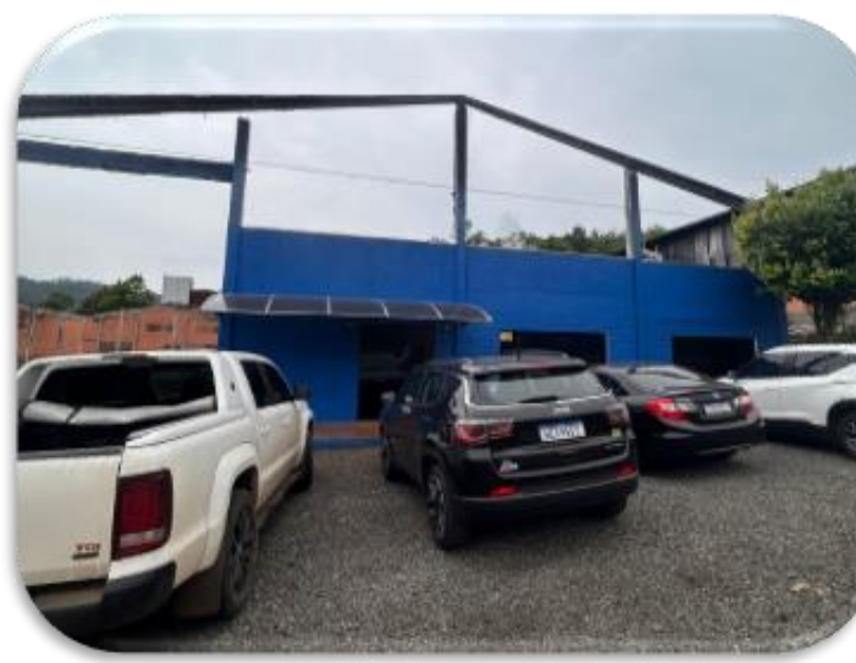
07. Reforma da sede antiga da AM PNEUS.
