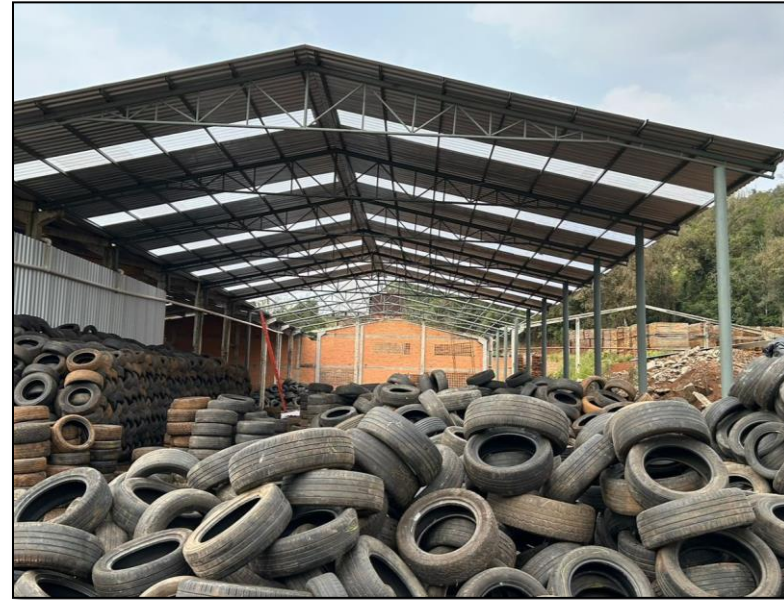
01. Estoques (Rua Tiradentes, nº 601)
