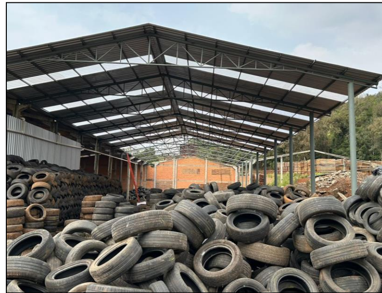
01. Estoques (Rua Tiradentes, nº 601)
