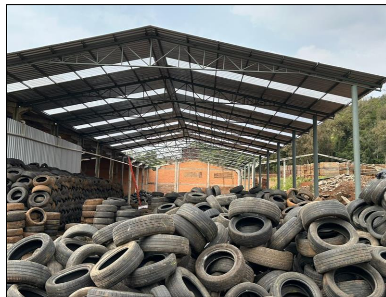
01. Estoques (Rua Tiradentes, nº 601)
