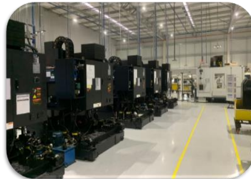
01. Operação com máquinas (São Leopoldo/RS)
