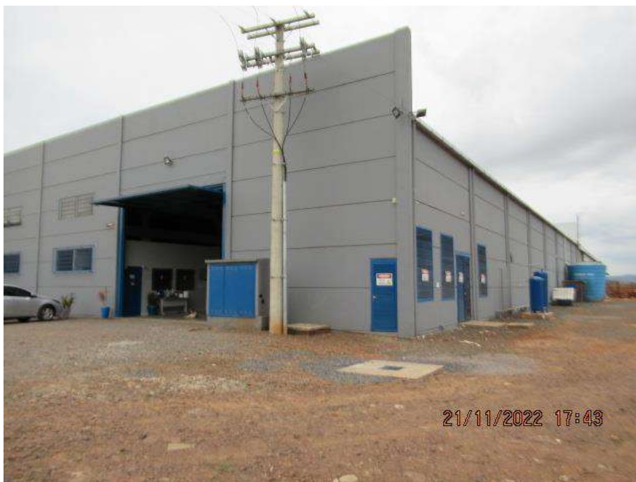
Fachadas frontal e lateral
