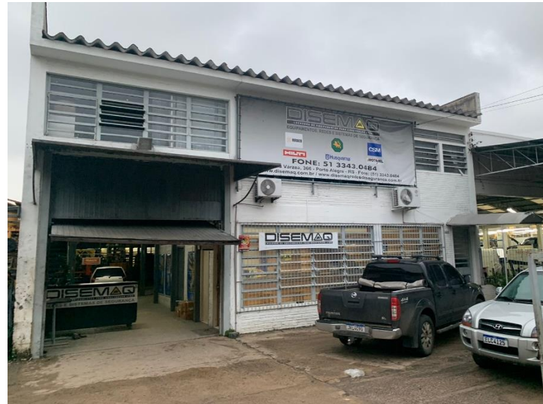
01. Fachada da sede da empresa
