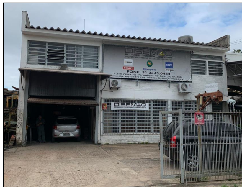
01. Fachada da sede da empresa
