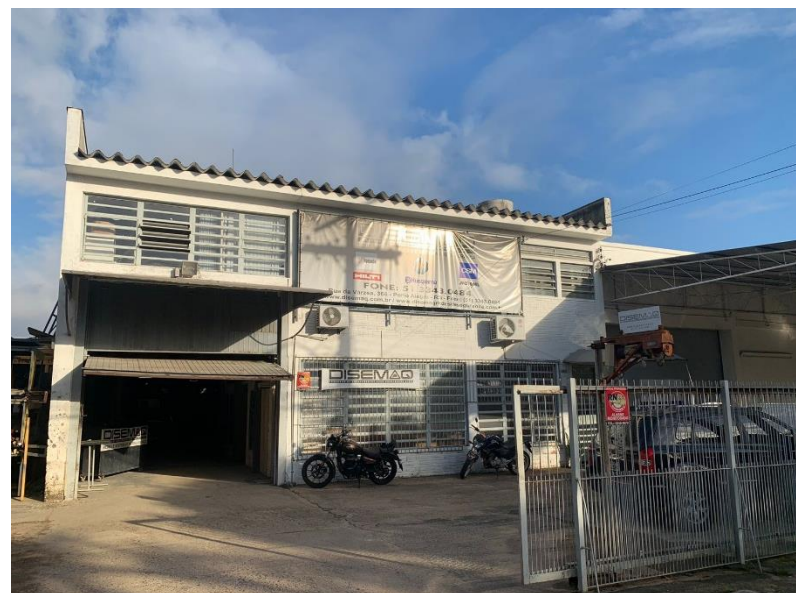
01. Fachada da sede da empresa
