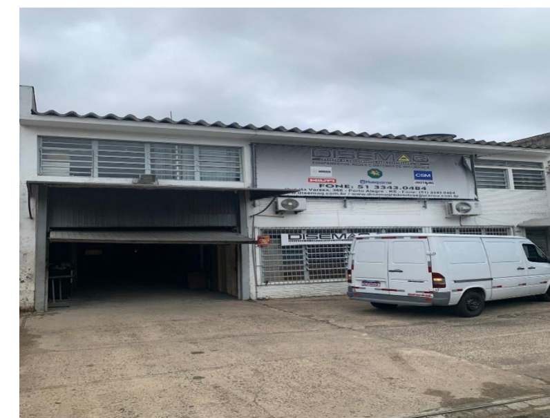
06. Fachada da sede da empresa
