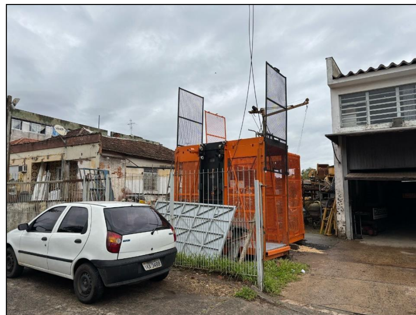
04. Elevador de Obra
