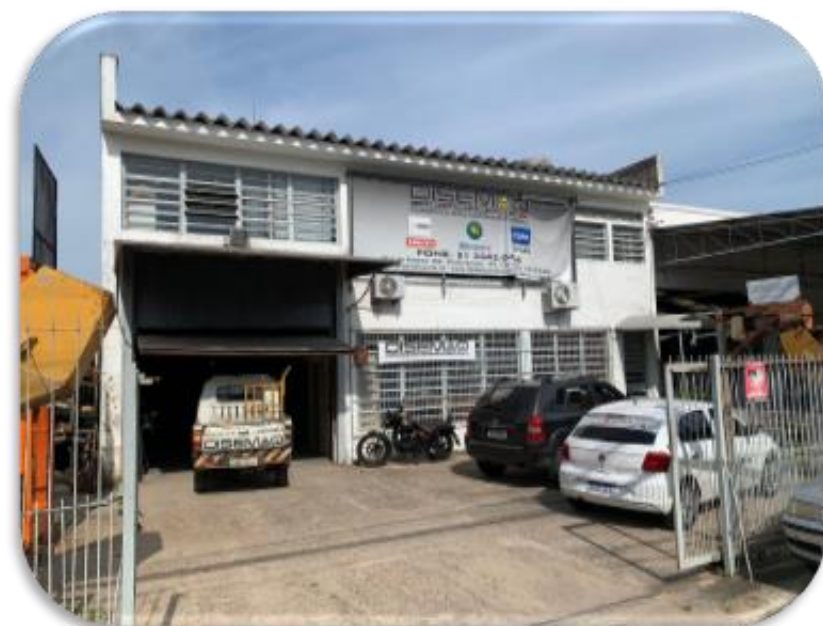
01. Fachada da sede da empresa
