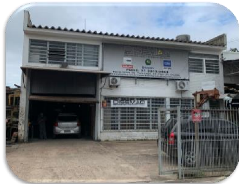
01. Fachada da sede da empresa
