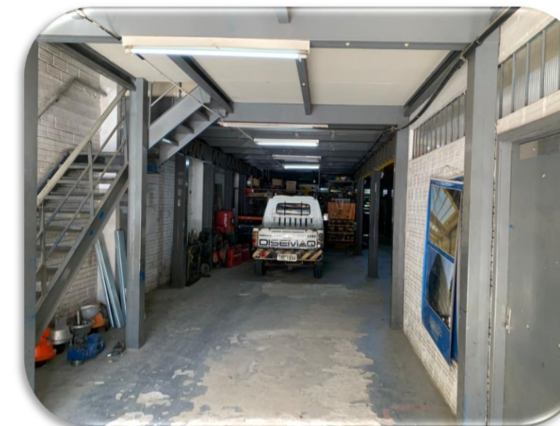
06. Entrada da área interna com equipamentos e ferramentas
