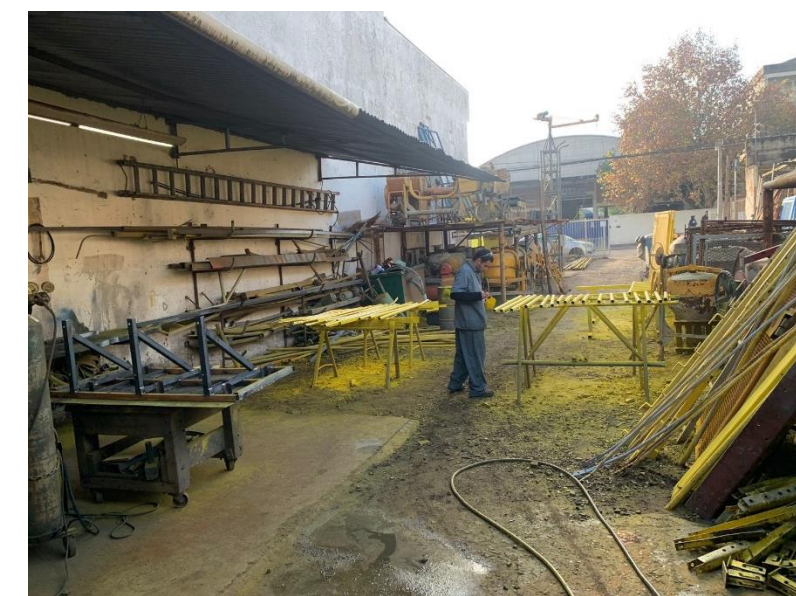
06. • Área externa com equipamentos e ferramentas
