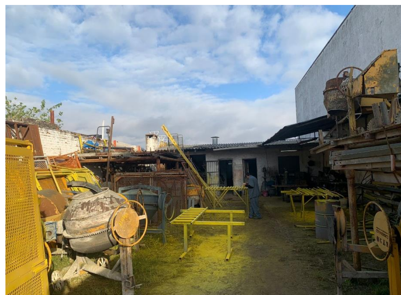
05. Área externa com equipamentos e ferramentas
