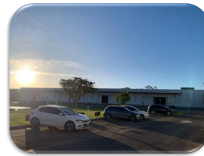
06. Área externa da sede
