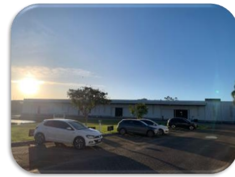
06. Área externa da sede
