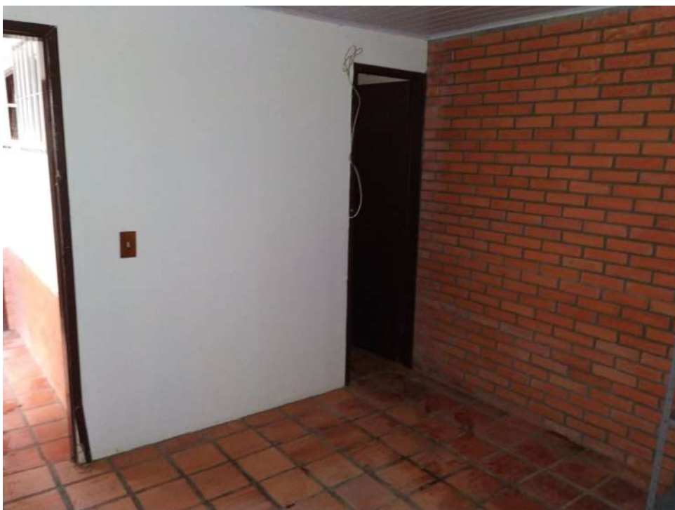
Foto 51: Suíte na construção ao fundo do lote
