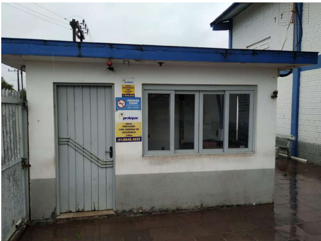
Foto 57: Detalhe da guarita
