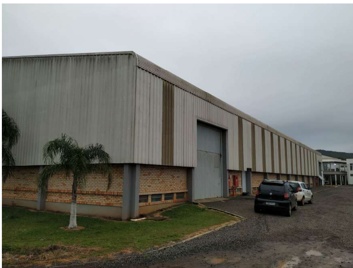
Foto 14: Detalhe externo pavilhão 1
