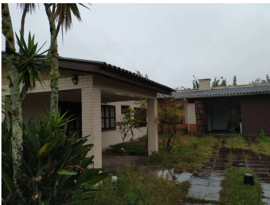
Foto 42: Foto externa da residência
