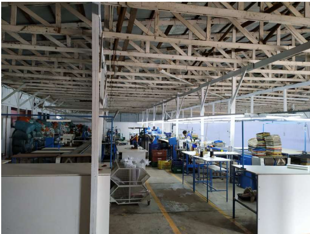
Foto 75: Detalhe interno do pavilhão
