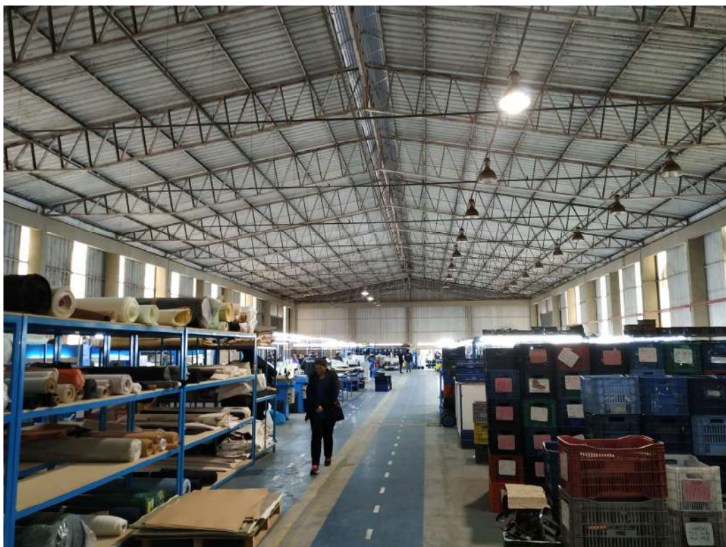
Foto 17: Detalhe interno do pavilhão
