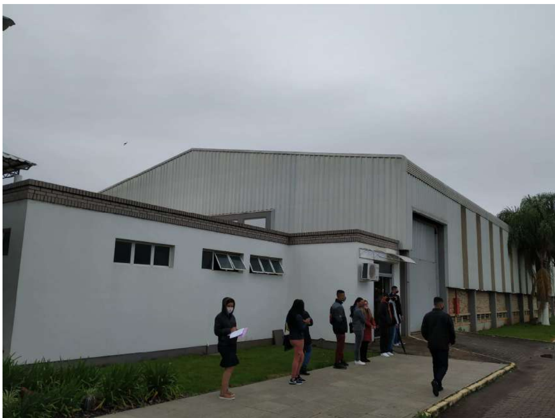
Foto 13: Detalhe externo pavilhão 1
