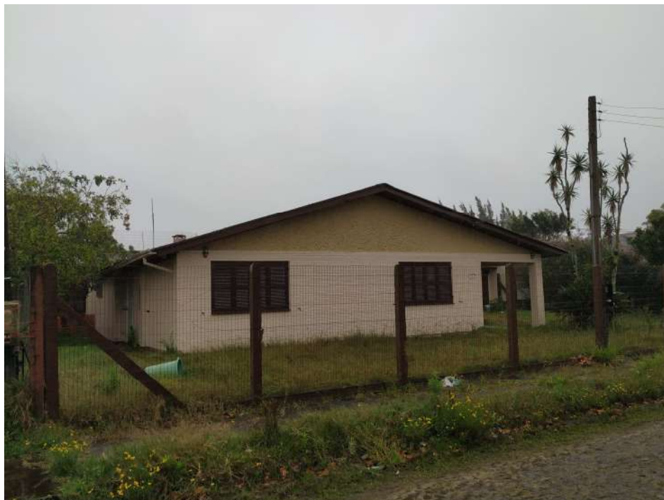
Foto 41: Foto externa da residência
