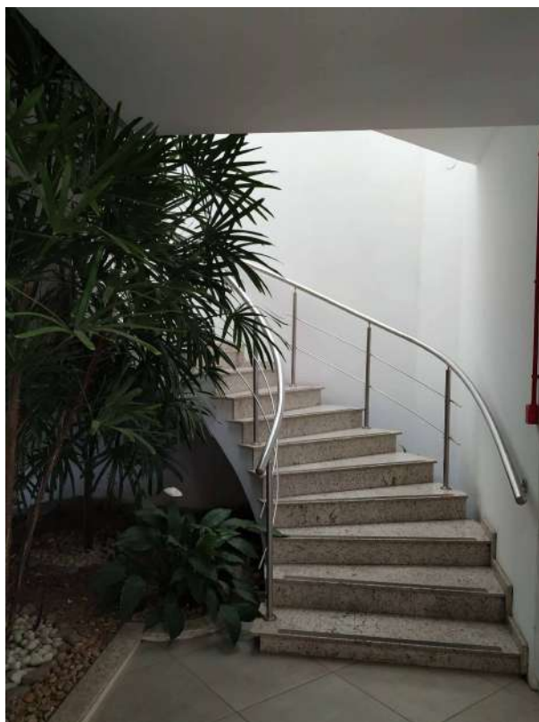
Foto 07: Detalhe da escada de acesso ao segundo pavimento
