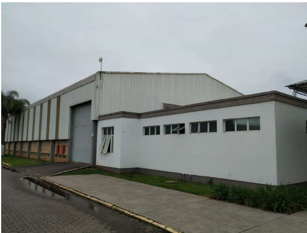
Foto 31: Detalhe externo pavilhão 4
