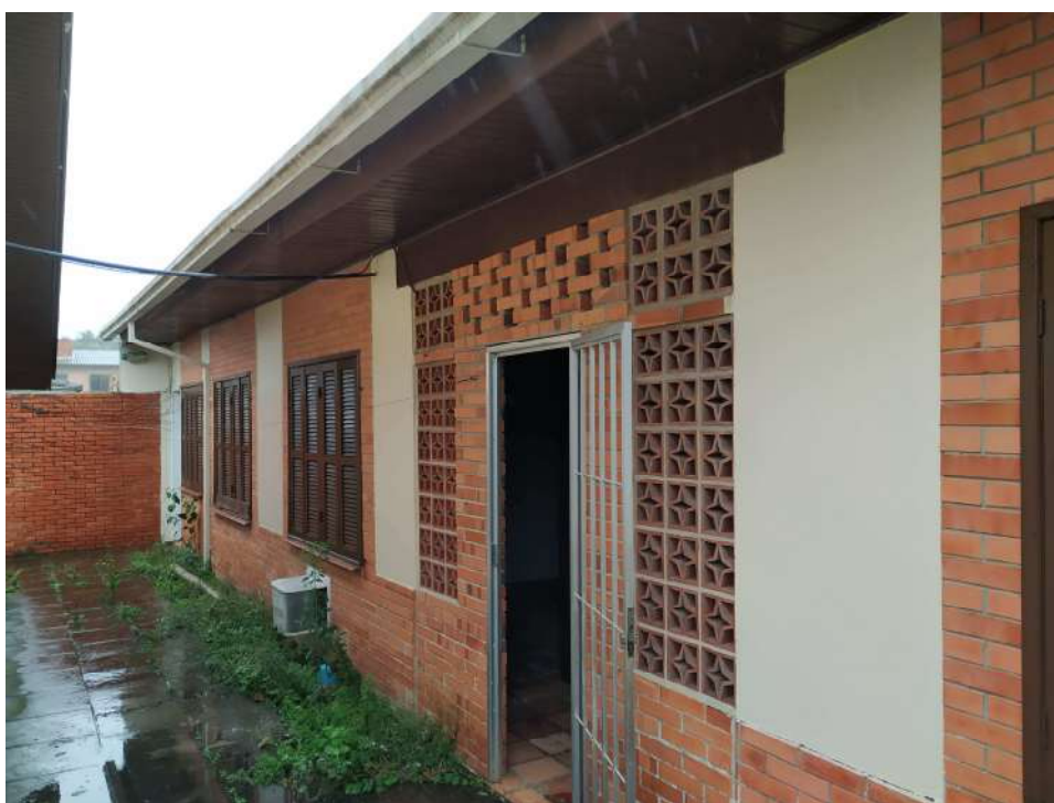
Foto 44: Detalhe externo da construção no fundo do lote
