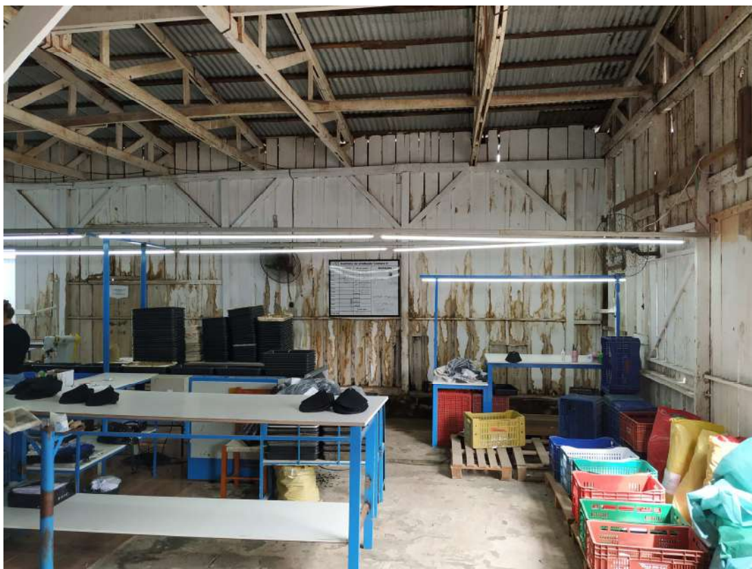
Foto 77: Detalhe interno do pavilhão
