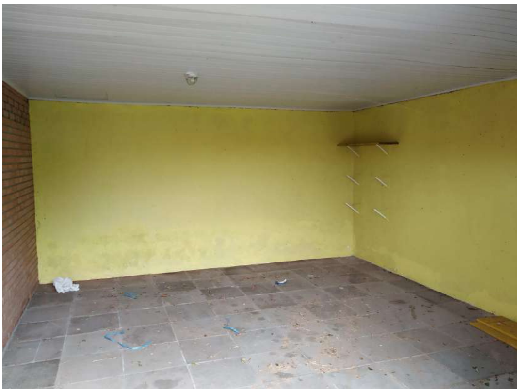
Foto 54: Garagem 2 - na construção ao fundo do lote
