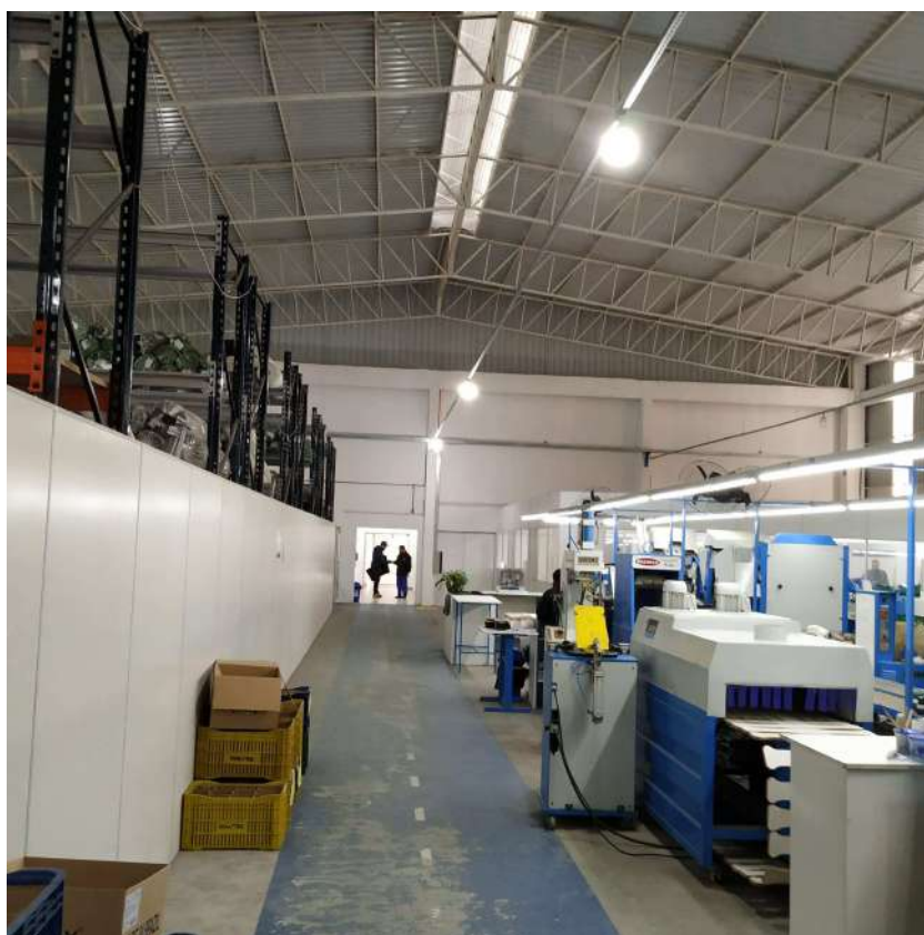
Foto 26: Detalhe interno do pavilhão 2
