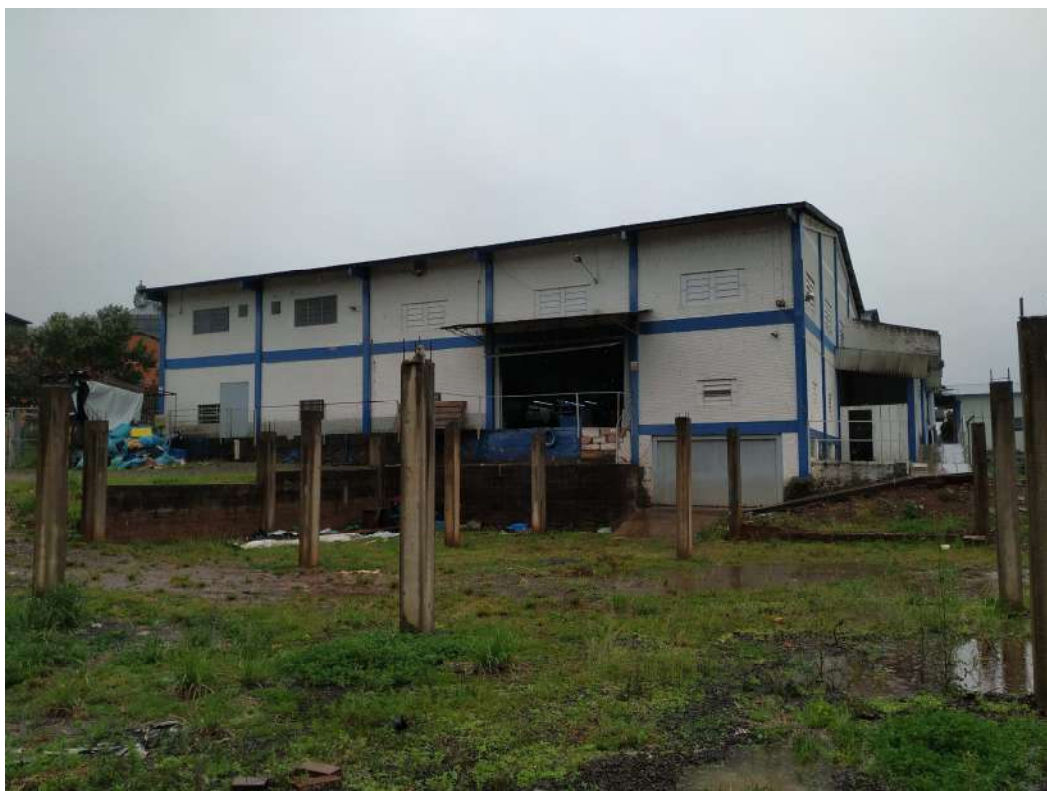
Foto 71: Detalhe da construção iniciada no terreno
