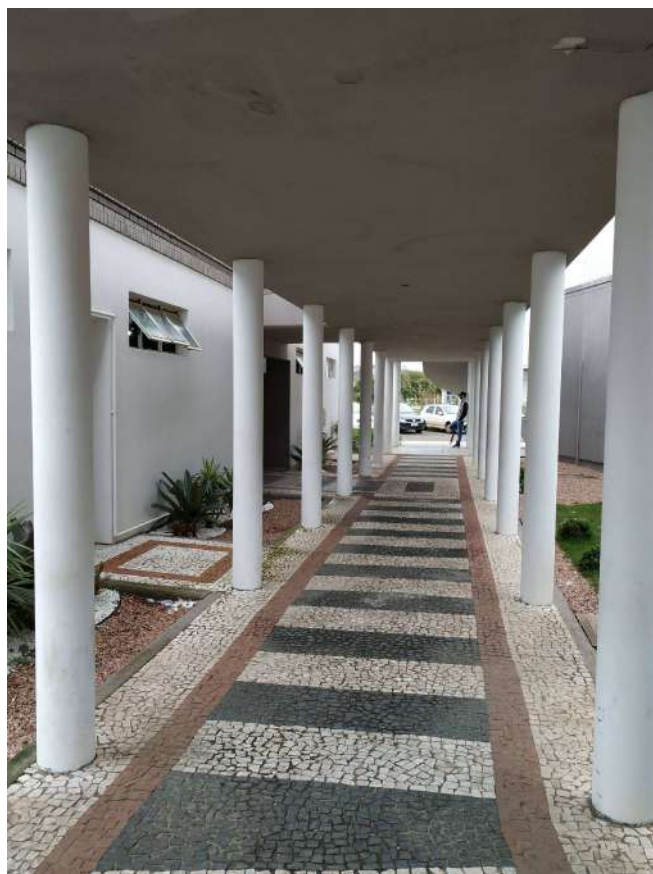
Foto 23: Circulação de acesso aos pavilhões
