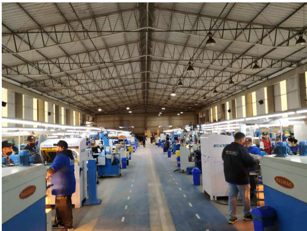
Foto 29: Detalhe interno do pavilhão 3
