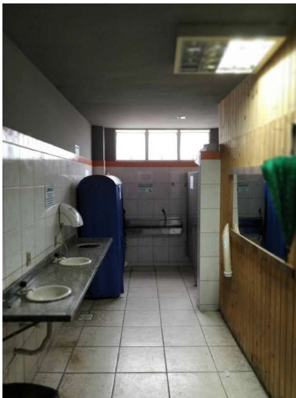
Foto 15: Detalhe do banheiro do pavilhão 1
