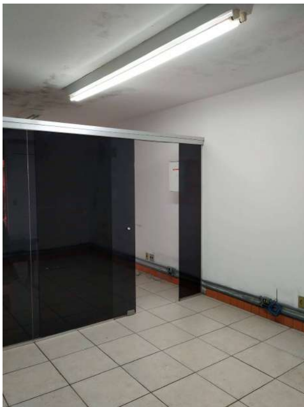
Foto 16: Detalhe da sala de apoio
