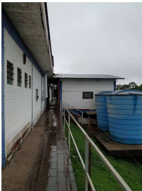
Foto 66: Detalhe reservatórios e anexo lateral
