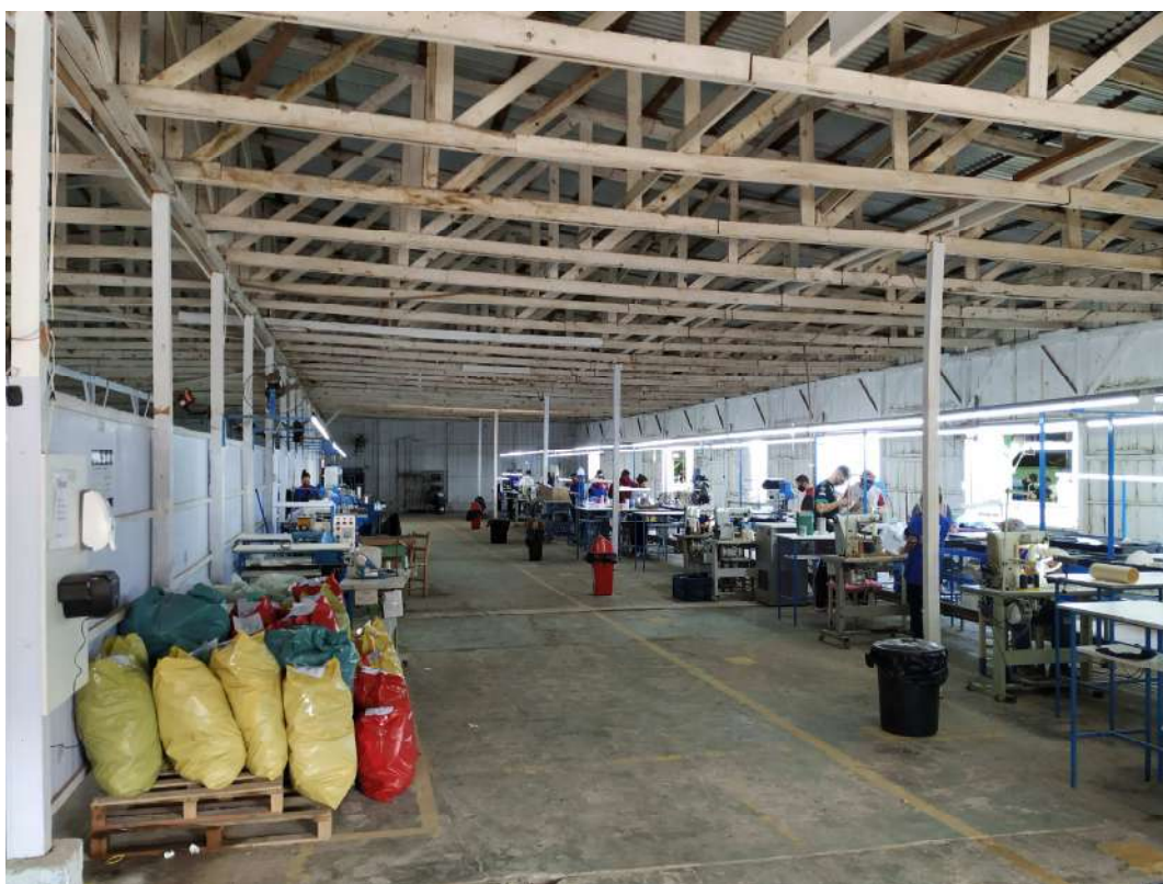
Foto 74: Detalhe interno do pavilhão
