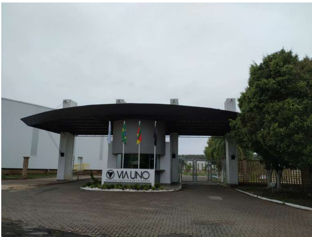
Foto 02: Detalhe da Guarita de acesso
