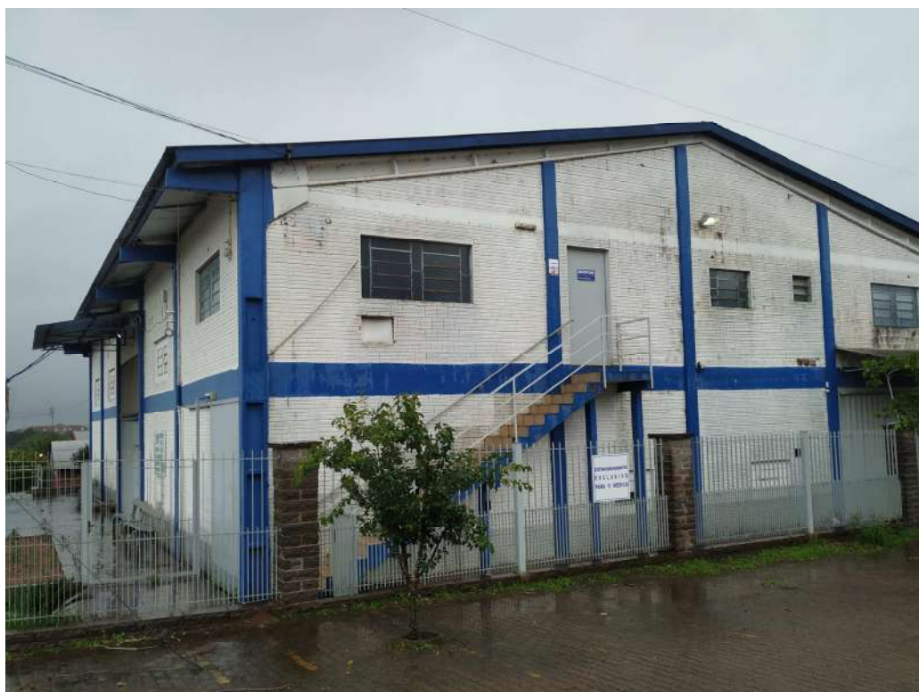
Foto 56: Fachada do imóvel
