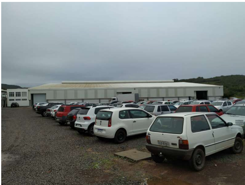
Foto 19: Detalhe do estacionamento dos funcionários
