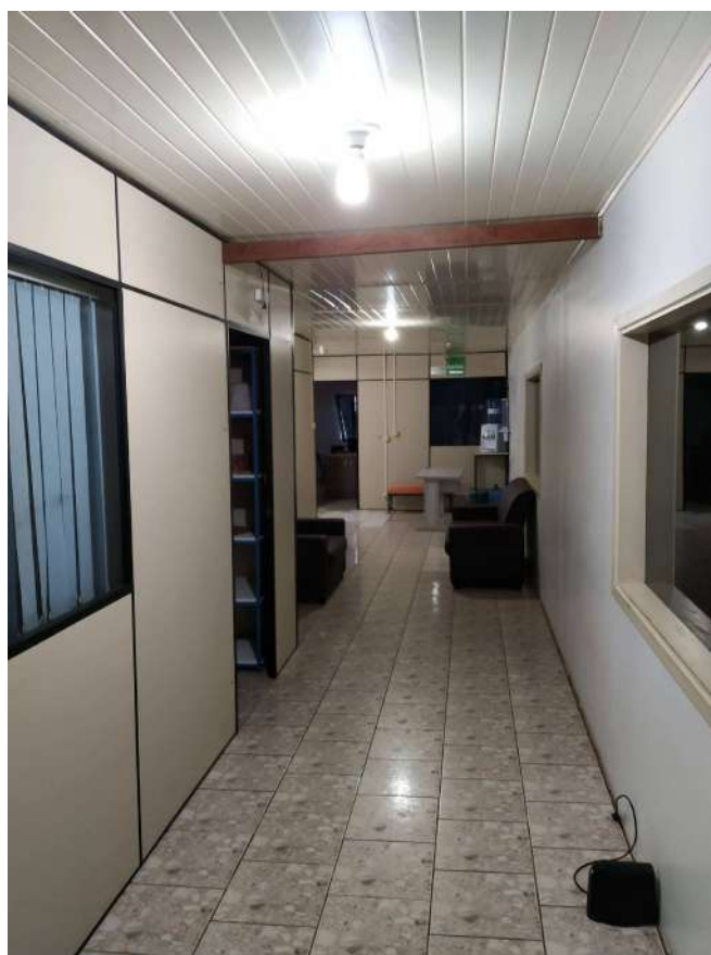
Foto 62: Detalhe da circulação junto aos mezaninos
