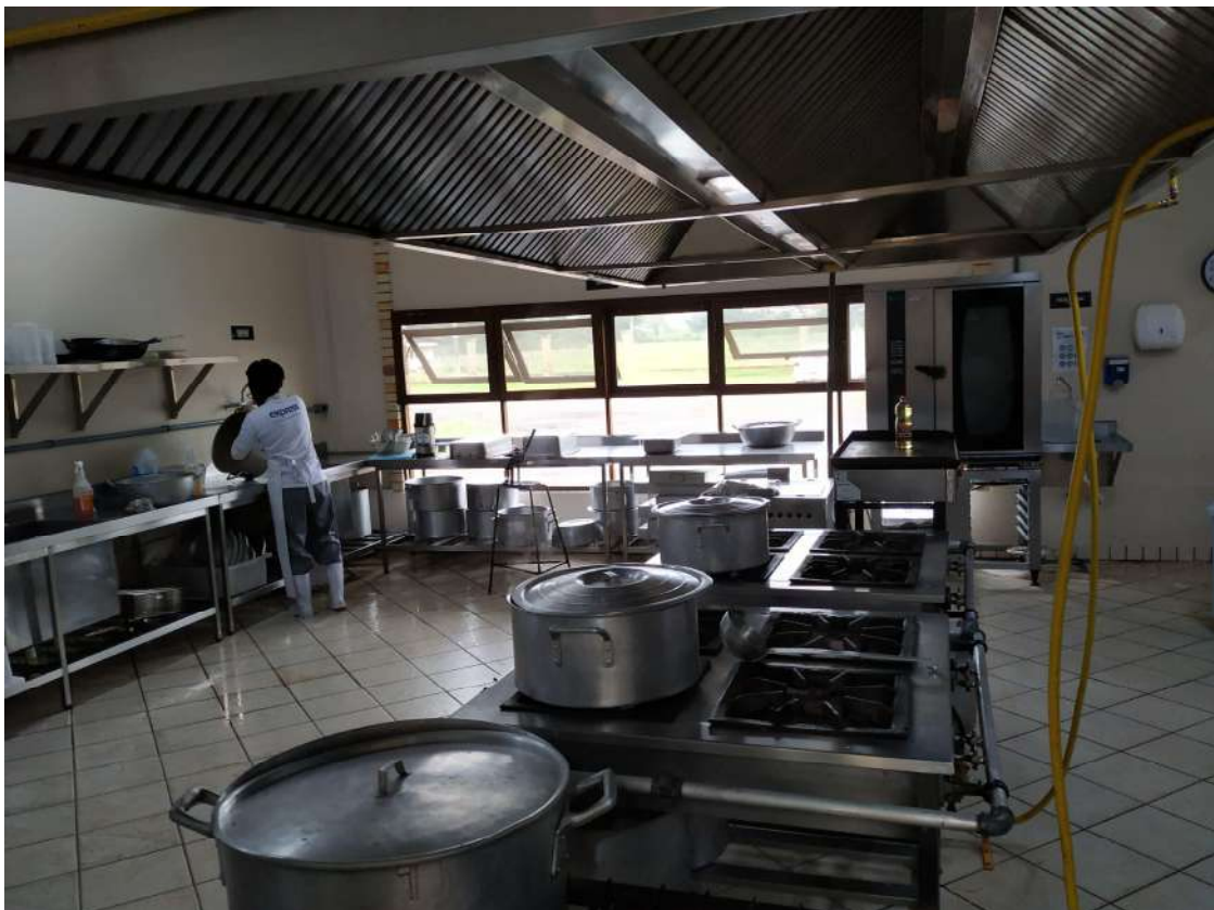
Foto 39: Detalhe interno da cozinha do refeitório
