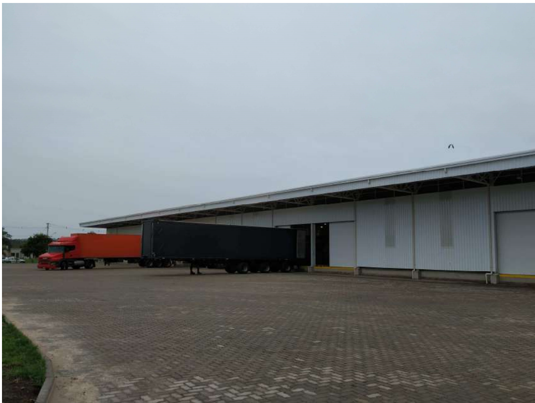
Foto 33: Detalhe externo pavilhão 5
