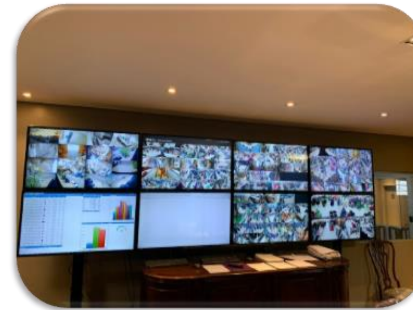
03. Área de controle
