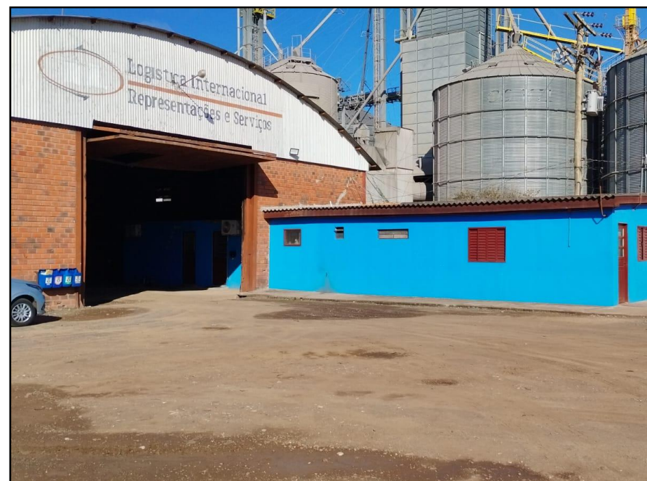
03. Entrada do galpão
