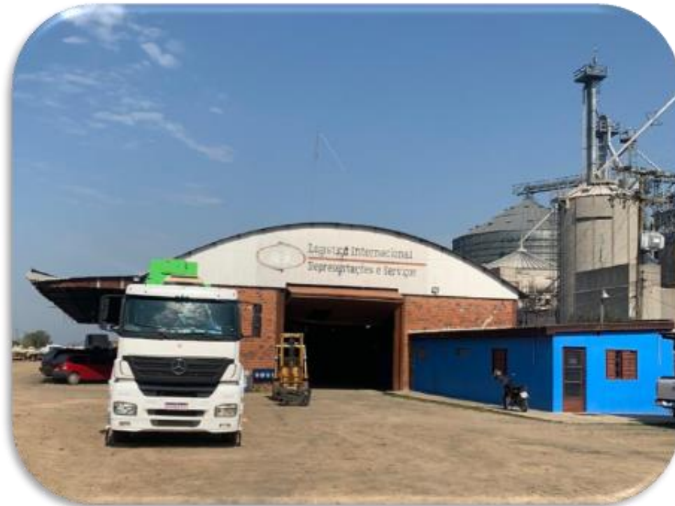
01. Entrada do galpão
