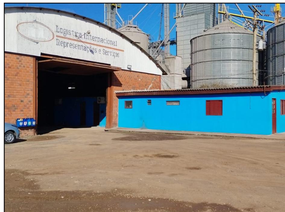
03. Entrada do galpão
