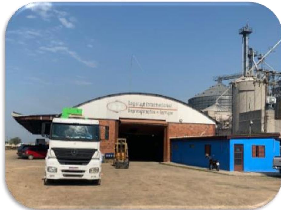
01. Entrada do galpão
