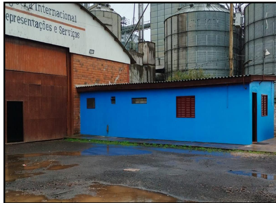
01. Entrada do galpão
