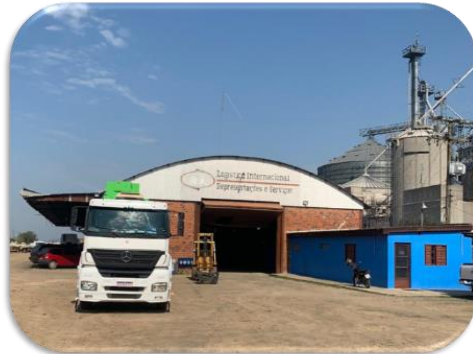
01. Entrada do galpão
